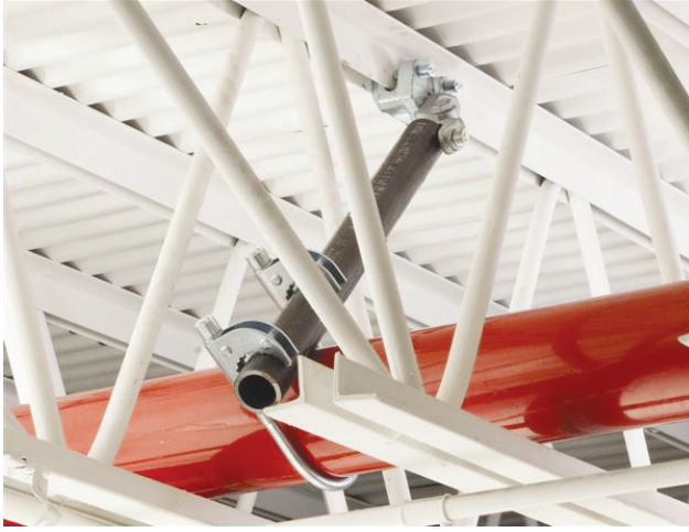
Şekil 7. Enine deprem askısı.
